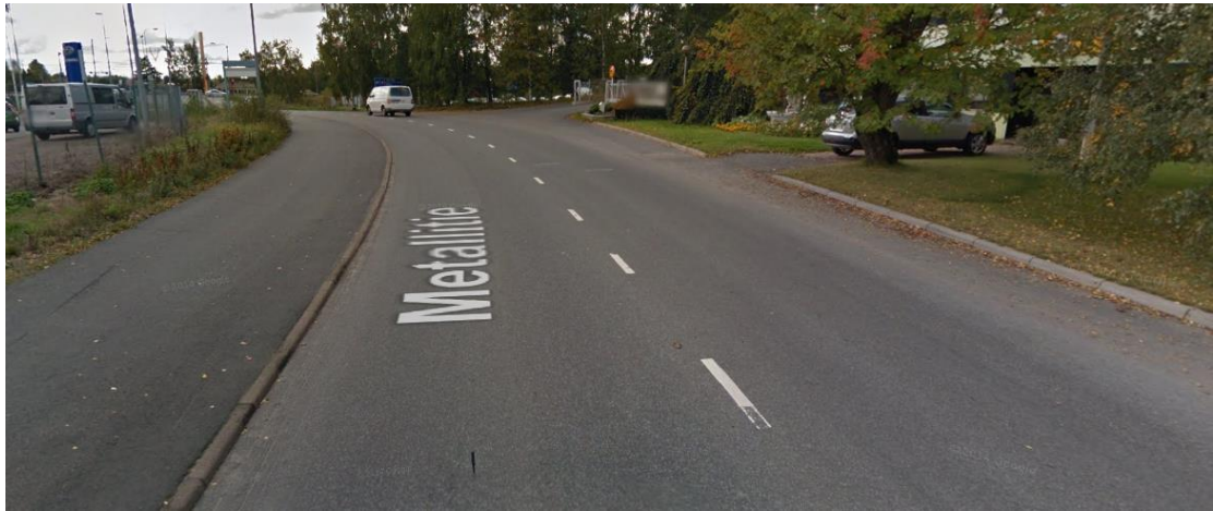
Kuva 31. Metallitien yhtenäiset reunakivet pitävät poikkeustilanteissa tulvavedet katualueella. GoogleStreetView 16 näkymä kohteesta.
