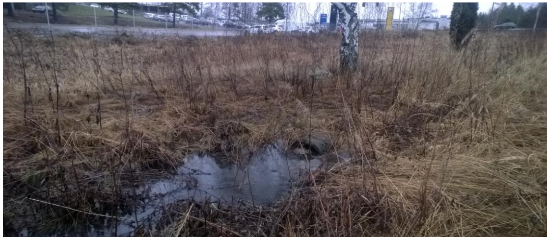
Kuva 4. Metallitien 400B hulevesiviemärin purku
