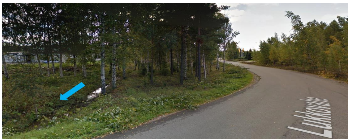
Kuva 16. Normaalitilanteissa Lukkovaheen itäpuolisen avo-ojan virtaama on nuolen osoittamaan suuntaan, eli pohjoiseen. Rankkasateiden aikana Kairakadun hulevesiviemäri tulvii Lukkovaheen itäpuoliseen ojaan, aiheuttaen takaisinvirtausta.
