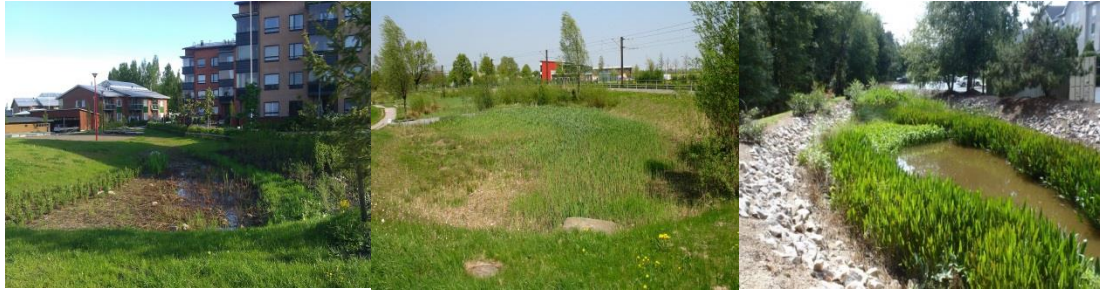
Kuva 276. Esimerkkejä painanteen rakentamisesta pehmeästi, ympäristöä mukailien.
