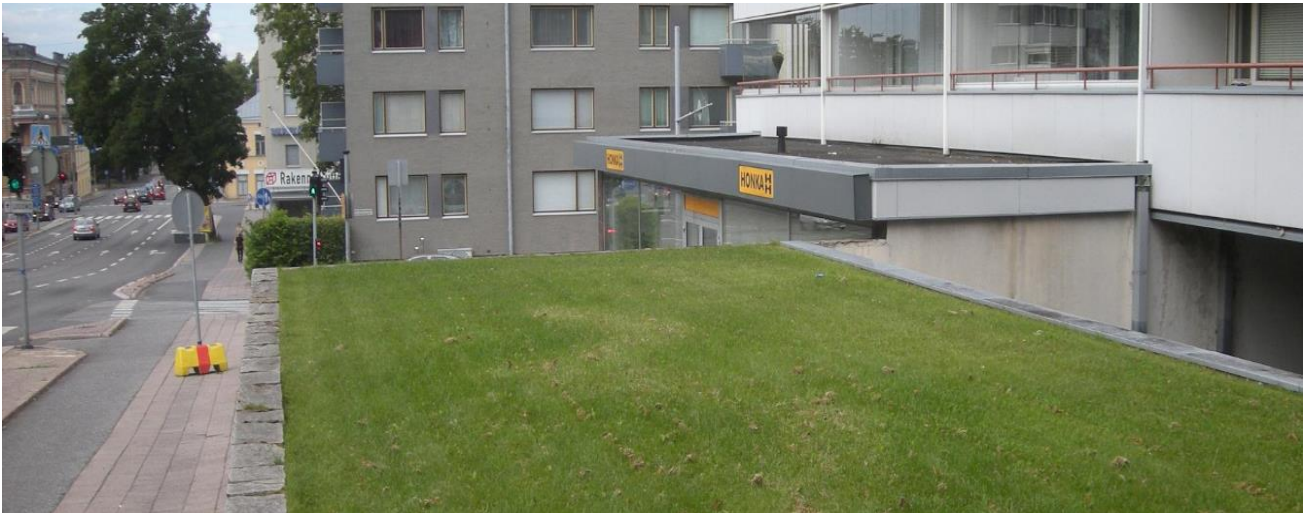
Kuva 20. Viherkatto autokatoksessa. Turku, Uudenmaankatu 8
