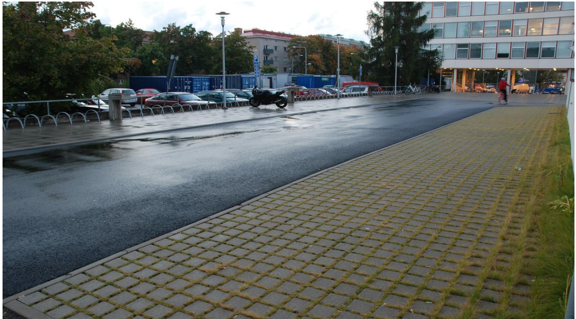
Kuva 19. Vettä läpäisevä päällyste Tampereen Sampolassa. 8
