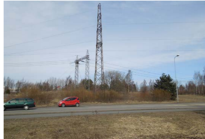
Kohde 5 b) Näkymä Kairakadun yli pohjoiseen kohti sähköasemaa.
