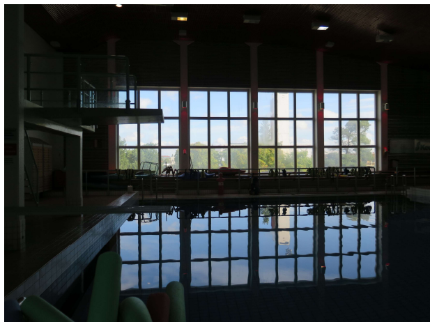
Yllä kuva näkymä alkuperäisen uimahallin allastilan ikkunoista pohjoiseen.
