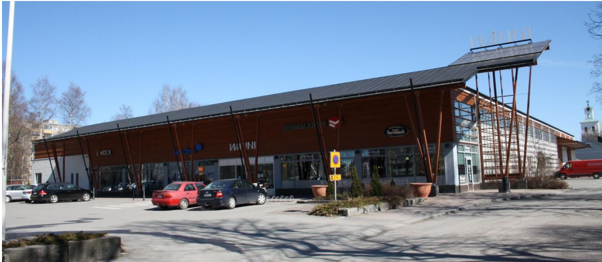
Kauppakeskus Wänni on uudehko rakennus Vanhan Rauman luoteispuolella
