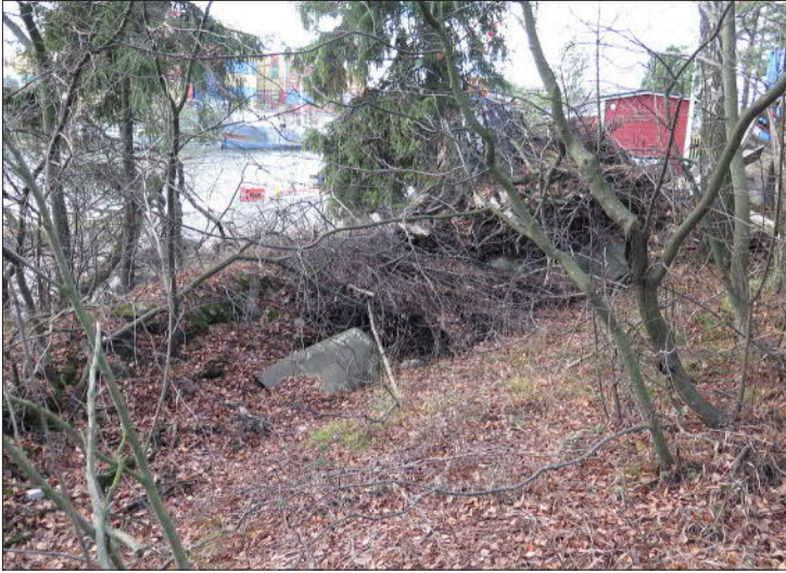
Petäjäksentie 234 pihapiirin länsipuolella sijaitseva ampumahauta oli inventointihetkellä peitetty pahoin puutarha- ym. jätteillä. Alakuvassa aivan Petäjäksiemen länsipäässä sijaitseva ranta-asema.
