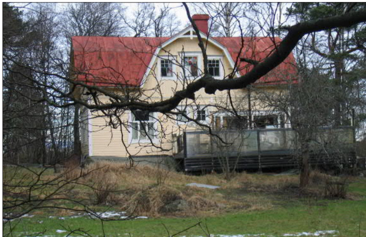
Tulipalossa tuhoutunut huvilarakennus kuvattuna vuonna 2008. (Valokuva Liisa Nummelin)
