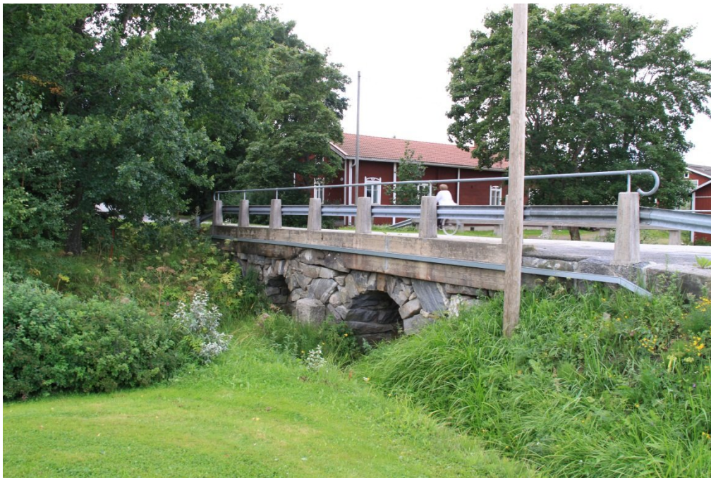
kuva 21. Unajantien kaksiaukkoinen kivinen holvisilta on valmistunut vuonna 1900
