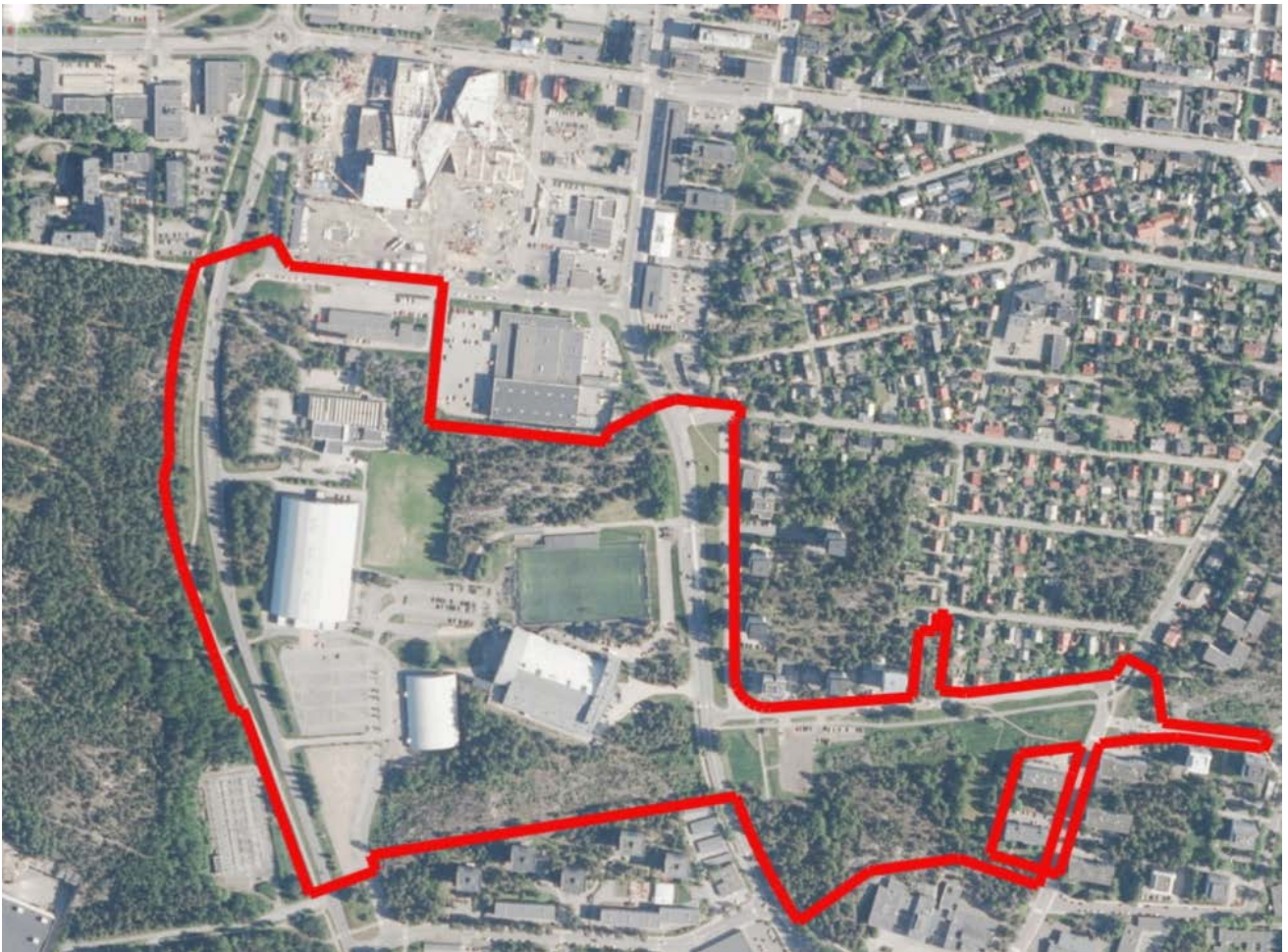
Kuva 27. Ilmakuvasa v. 2022 näkyy kaavarajauksen pohjoispuolella rakennusvaiheessa oleva Karim kampus. Kuvasta on havaittavissa Rauman lyseon purkamisen aiheuttama merkittävä vaikutus Sahankadun ympäristön 1960–70-lukujen ajalliseen sekä maisemalliseen kokonaisuuteen.
