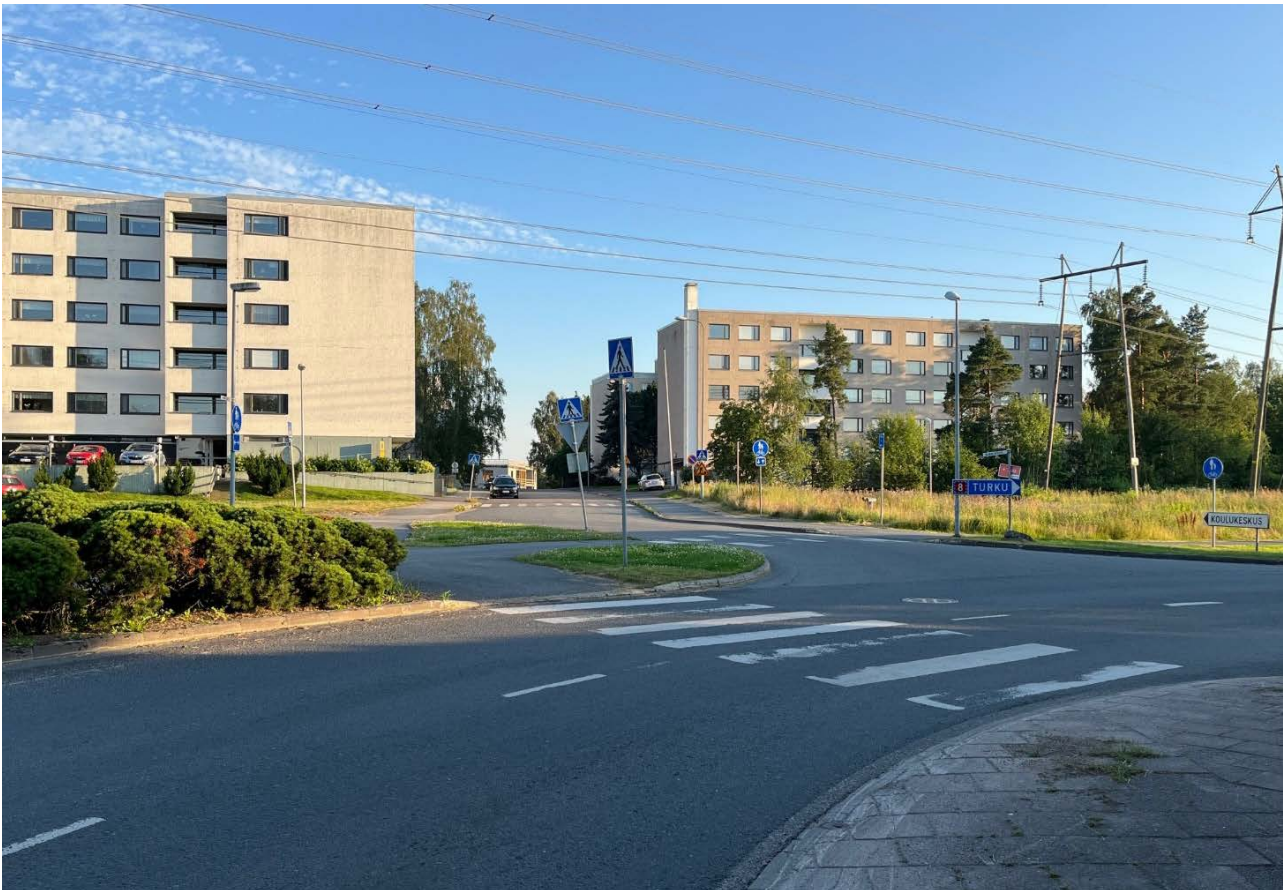
Kuva 14. Pohjanlahden rantatien linjaus kaava-alueelle nykytilassaan kaupunkikatuna. Kadun vasemmalla puolella sijaitsee Hirsikadun asuinalue ja oikealla puolella Nummenvaheen kerrostalot. Kerrostalojen välistä erottuu rakenteilla oleva Nanunkallion koulu.
