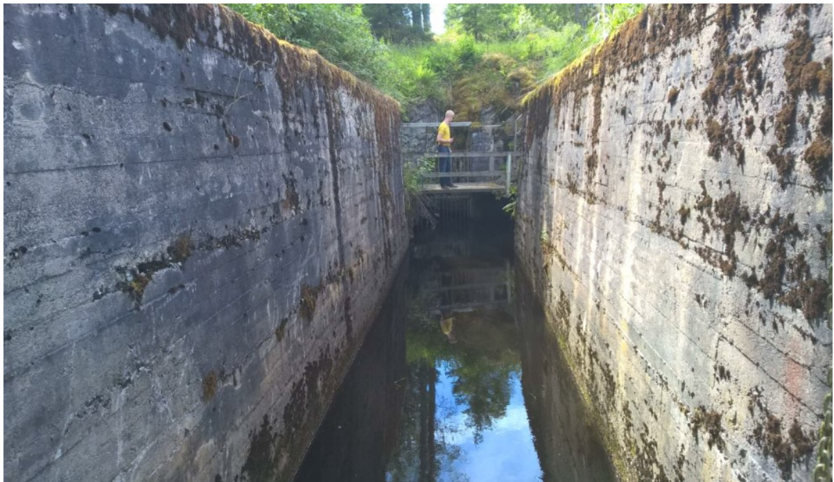
Kuva 2-1: Raakavesikanavan kalliotunneliosan alku kaava-alueen koillispuolella.
