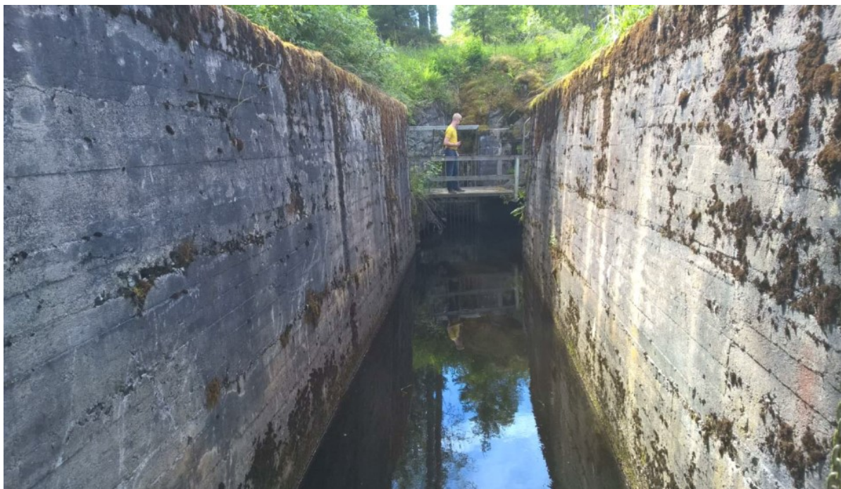
Kuva 2-1: Raakavesikanavan kalliotunneliosan alku kaava-alueen koillispuolella.
