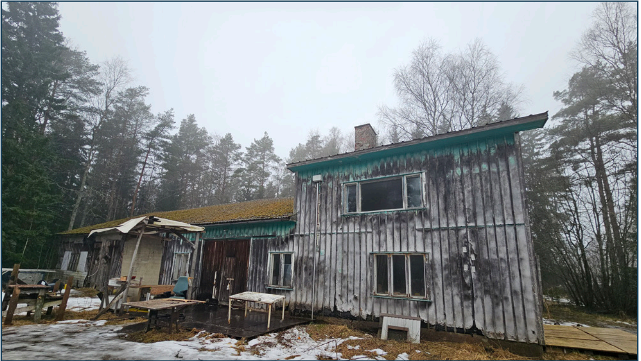
Kuva 4. Koiviontie. Huonokuntoinen päärakennus, jossa kaksi eri korkuista osuutta.
