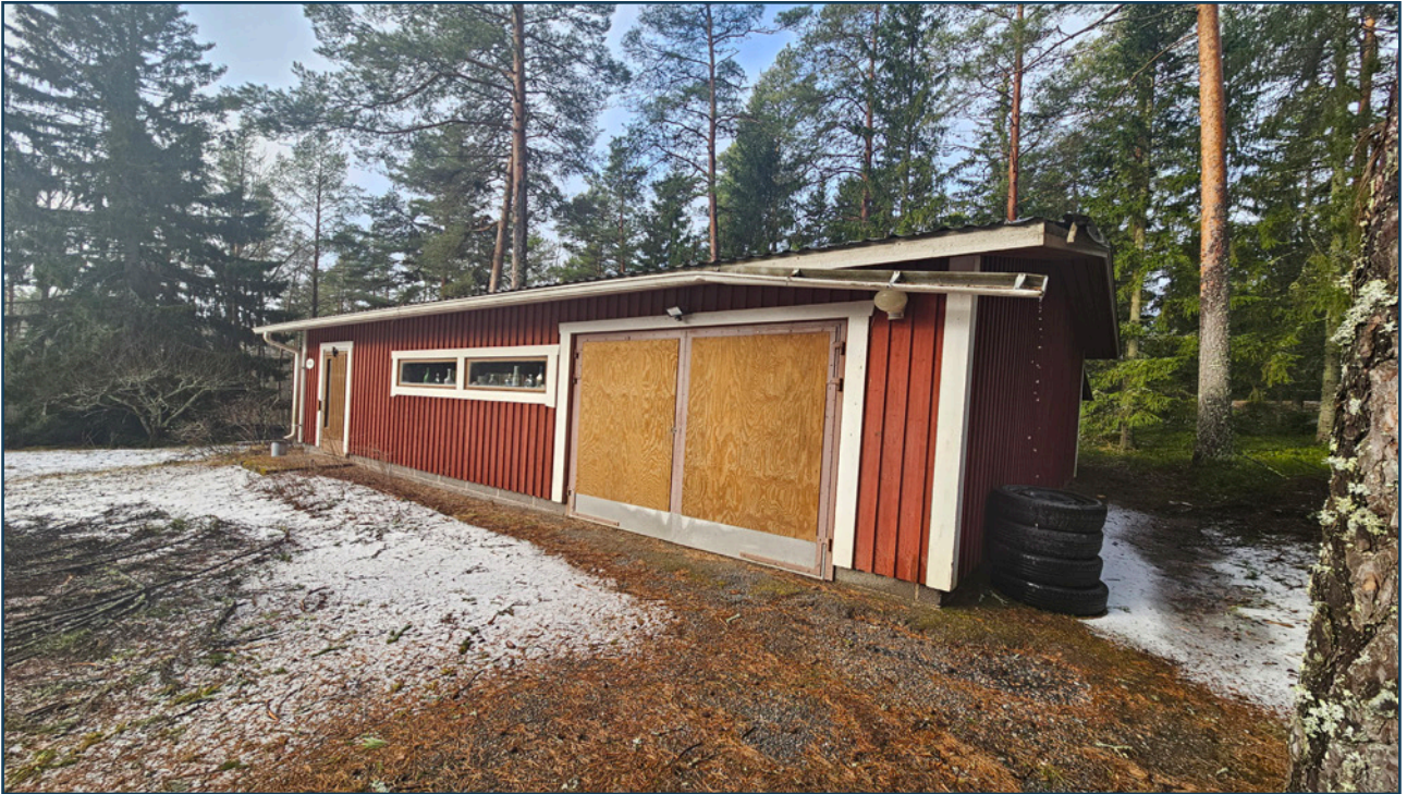
Kuva 10. Kuivassuontie 4. Autotalli oli hyväkuntoinen ja liian tiivis.
