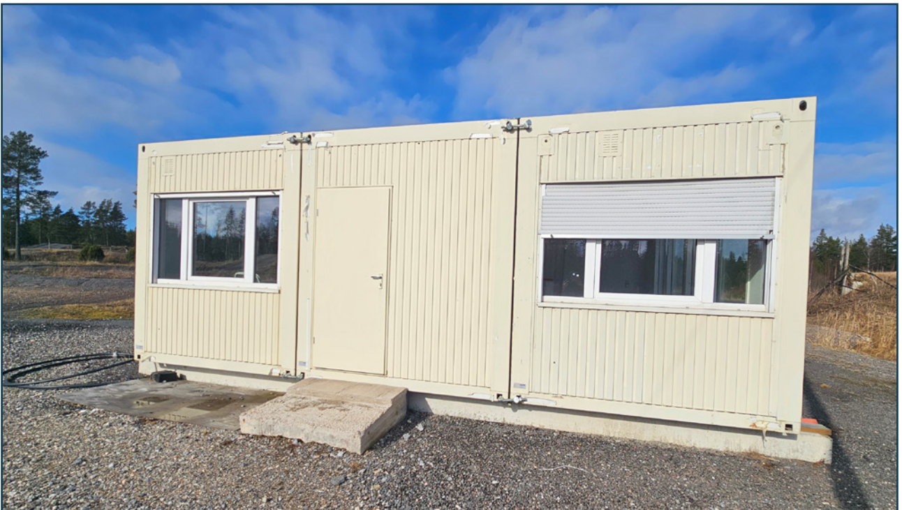
Kuva 21. Moottorirata. Peltirakennus oli kauttaaltaan liian tiivis.
