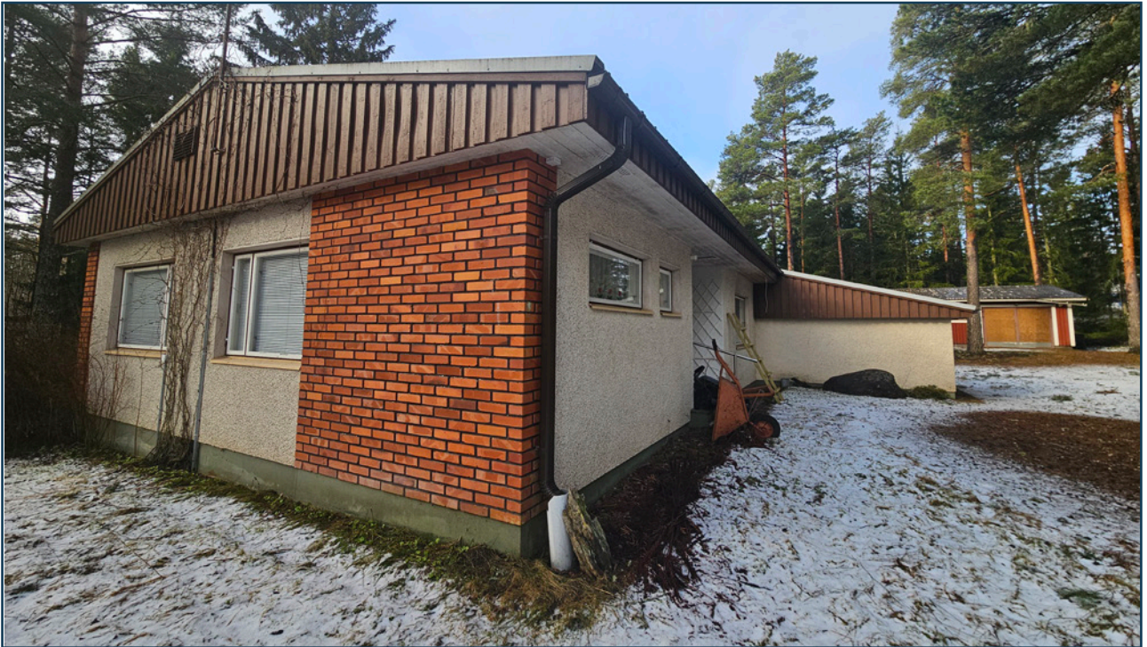
Kuva 9. Kuivassuontie 4. Kohtalaisessa kunnossa oleva päärakennus.
