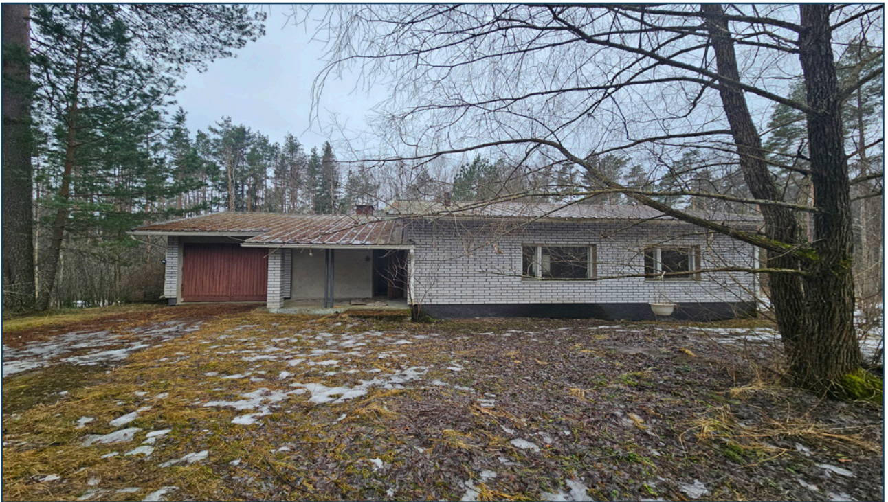
Kuva 7. Kuivassuontie 2. Kohtalaisessa kunnossa oleva päärakennus
