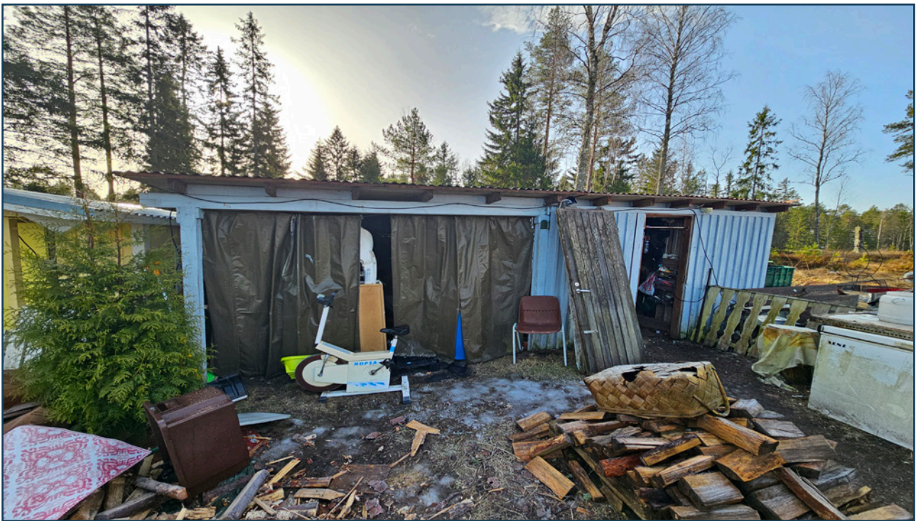
Kuva 12. Perkkotie 130 A. Piharakennukset olivat liian vetoisia ja suojaattomia lepakoille.
