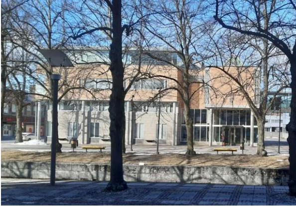
Rauman uuden kaupungintalon pääjulkisivu Kanalinrannasta kuvattuna. (2024, Rauman kaavoitus)
